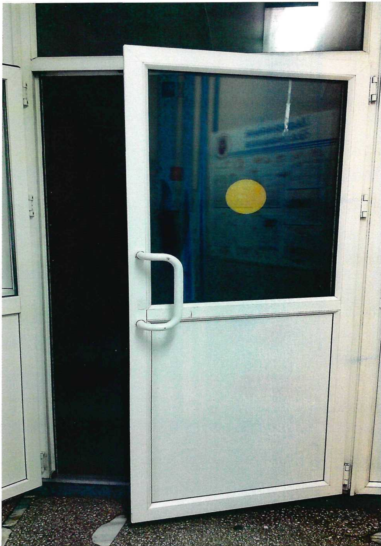
Фото21: Входная дверь на лестницу
