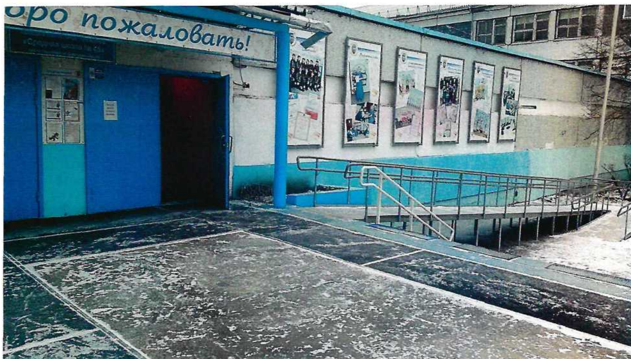
Фото20: Главный вход (вид на пандус)
